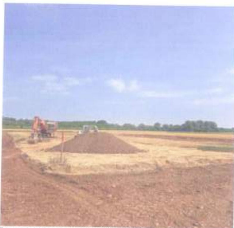
Slika 7 : Trenutno stanje predmetne lokacije i parcele na kojoj je planirana farma pilića
